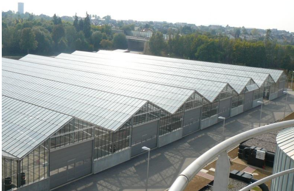
Slika 2.6. Primjer postrojenja za solarno sušenje (Luksemburg), 6.300 m 2 , 150,000 ES
